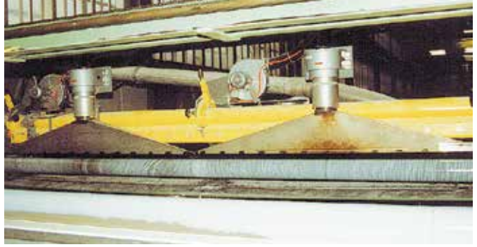
2 台加热器和2 台鼓风机用于干燥水泥浇注管道·2 个宽槽风嘴提供均匀分布的热风
