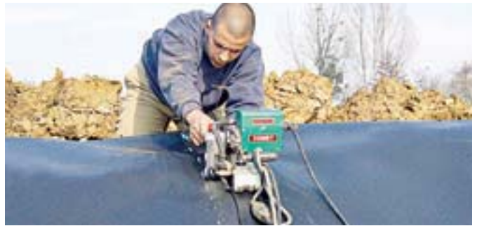
... 在垃圾填埋场施工。
