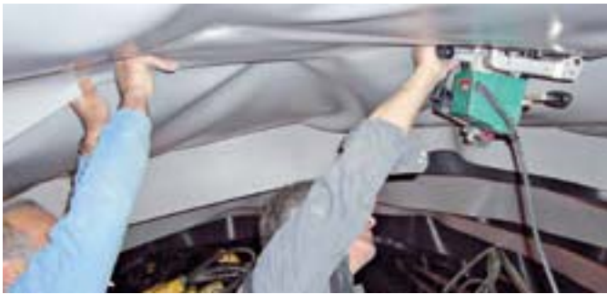
COMET 在隧道中施工 ...
