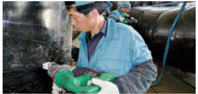
中国的客户使用 FUSION 2 焊接化工储槽。
