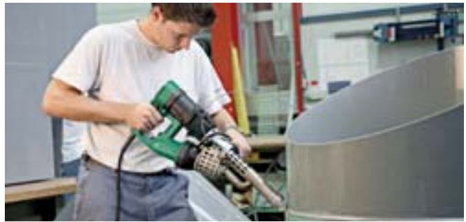
使用 FUSION 3C 焊接 V 型焊缝。
